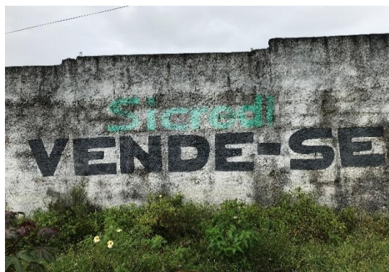
Foto 8 - Muro do terreno avaliando
