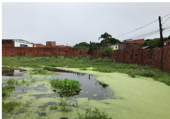
Foto 18 - Vista interna pontos alagados do terreno
