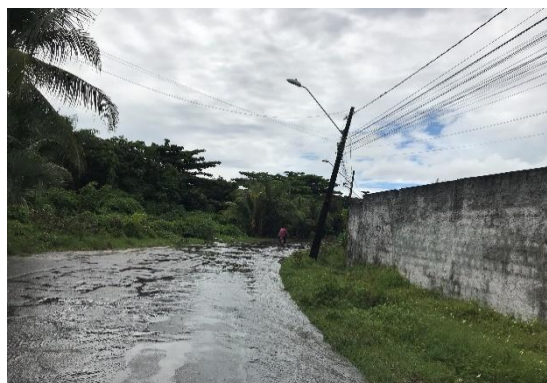
Foto 6 - Muro do terreno avaliando
