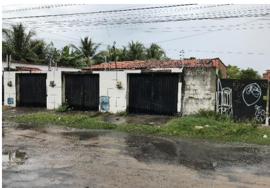
Foto 23 - Imóveis vizinhos ao terreno avaliando
