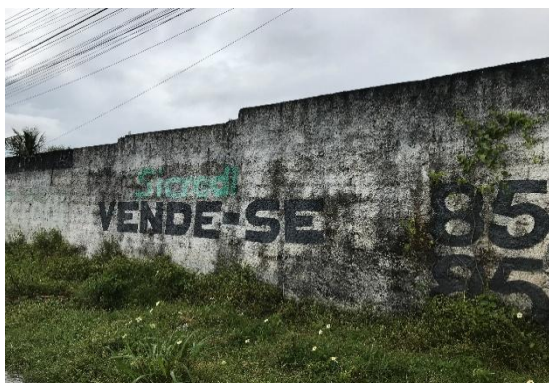
Foto 5 - Muro do terreno avaliando
