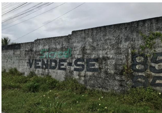
Foto 7 - Muro do terreno avaliando
