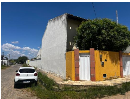
Foto 6 - Vista do imóvel avaliando
