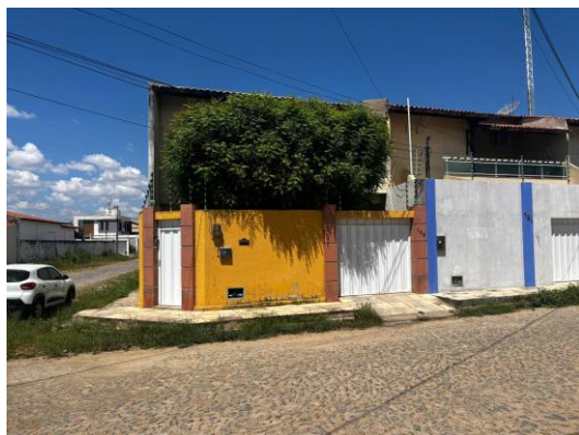
Foto 5 - Vista do imóvel avaliando
