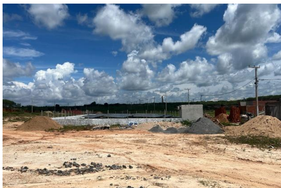
Foto 19 - Frente do loteamento, construção usina fotovoltaica
