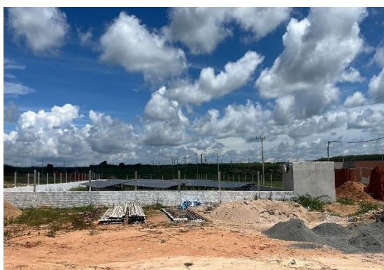
Foto 21 - Frente do loteamento, construção usina fotovoltaica
