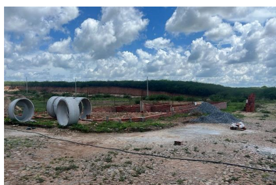
Foto 20 - Frente do loteamento, construção usina fotovoltaica
