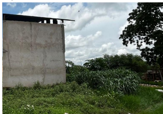
Foto 10 - Vista frontal do terreno com acesso fechado para os fundos
