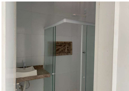
Representação Banheiro social Descrição Data Foto 08/03/2024
