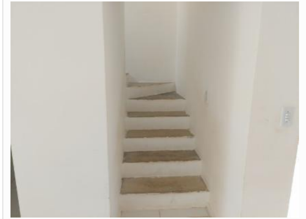
Escada de acesso ao pav. superior
