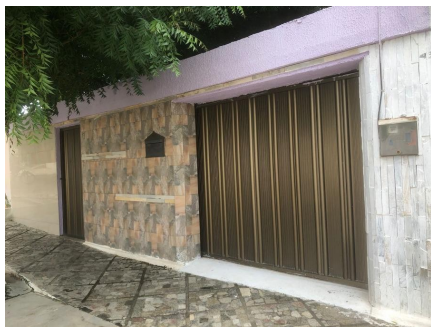
Representação Fachada Principal Descrição Fachada do imóvel Data Foto 16/03/2022
