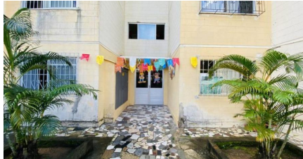
Representação Fachada Principal Descrição Data Foto 13/07/2023
