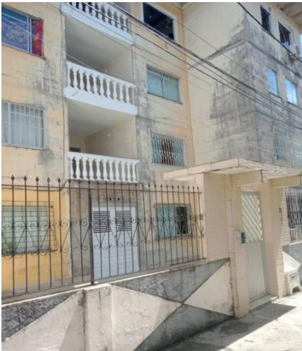
Representação Fachada Principal Descrição Data Foto 13/07/2023
