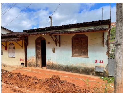
Representação Fachada Principal Descrição Data Foto 24/03/2022
