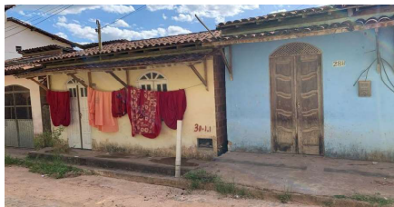
Representação Fachada Principal Descrição Data Foto 08/01/2024
