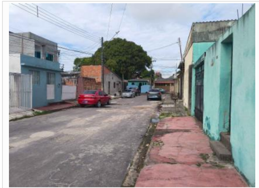
Logradouro de situação
