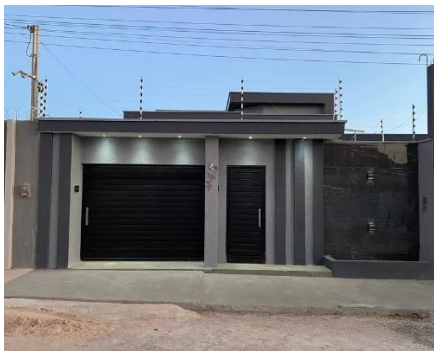
Representação Fachada Principal Descrição Data Foto 05/03/2024
