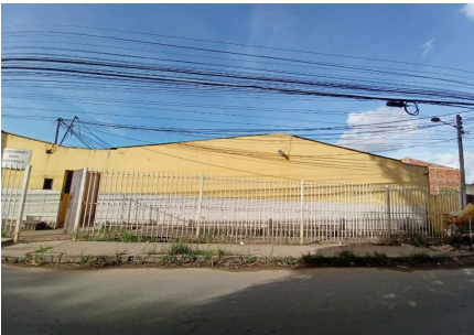
Representação Fachada Principal Descrição Data Foto 17/05/2023
